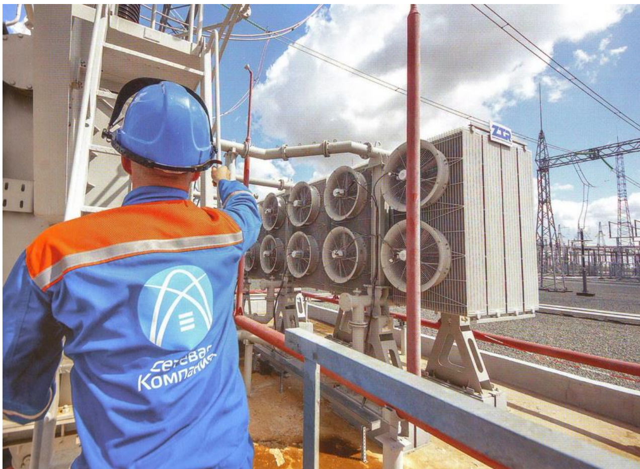
Габдуллин Ренат при пуско-наладочных работах на ПС 500 кВ "Щелоков"
