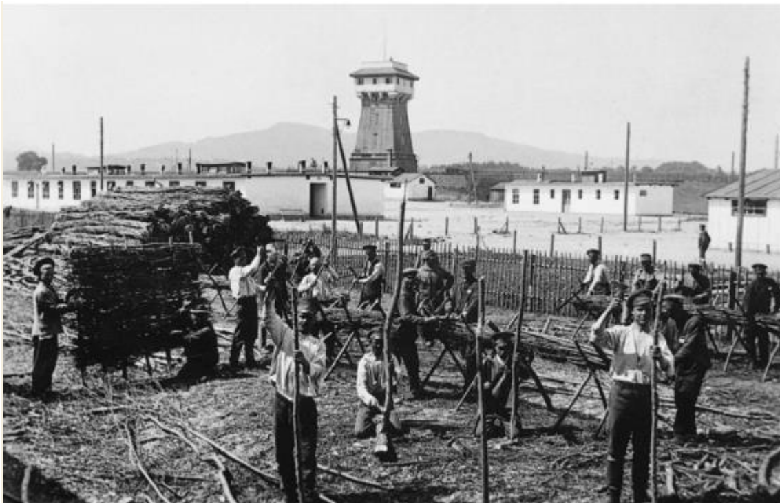
Строительство лагеря для военнопленных в Визельбурге, Австро-Венгрия
