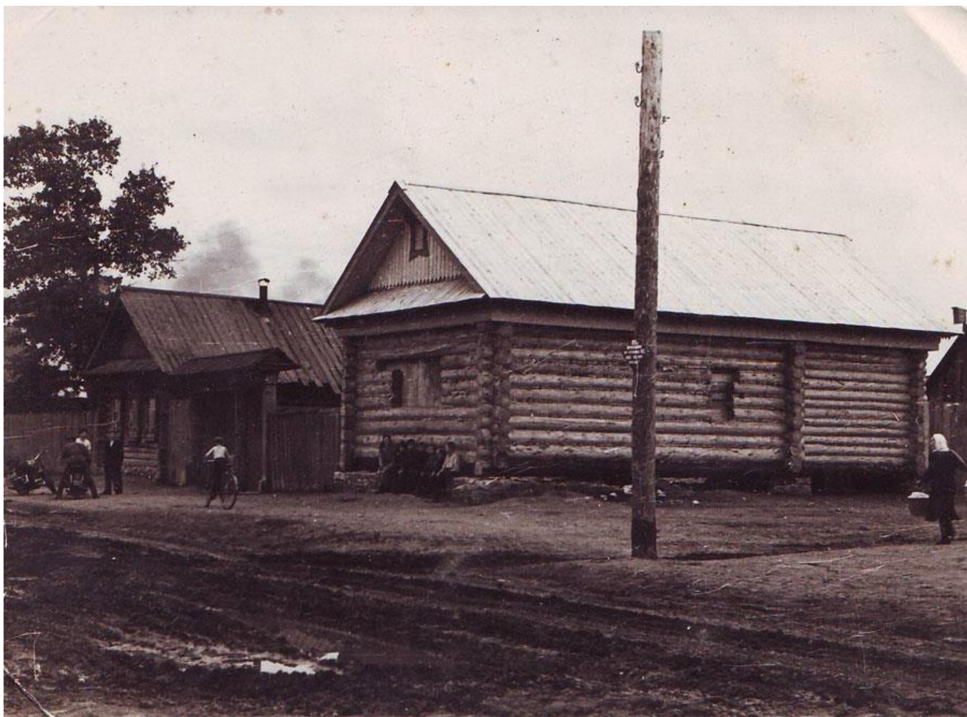
21.06.1959 год. Хуснутдинова Габделхака старый дом, рядом строящийся (теперешний) дом
